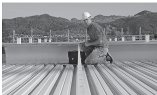
Massaufnahme am Bau (Vorgehen gemäss Seite 7-9)
